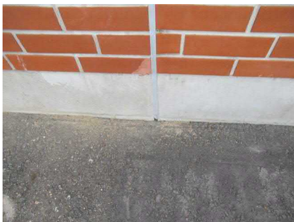
Elementtisauma auki maanpinnan tasalta (käsitelty kohdassa: Ulkoseinät
