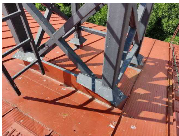
Letkutornin jalustan läpivientejä paikattu
