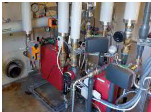
Lämmönjakopaketin sähköistystä
