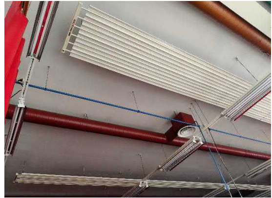
Kalustohallin kattosäteilijä
