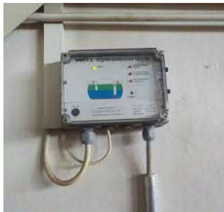
Öljynerotuskaivon ohjauskeskuksen sähköistystä
