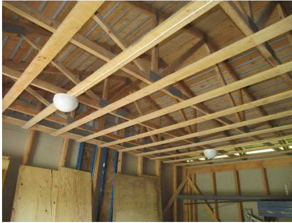
Yleiskuva varastorakennuksen sisäpuolelta
