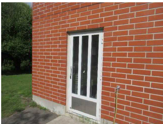
Teräs-/lasiovi rakennuksen päädyssä
