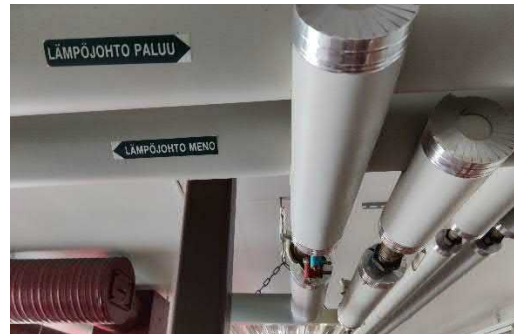
Lämpölinjat kalustohallissa. Eristykset hyvässä kunnossa.
