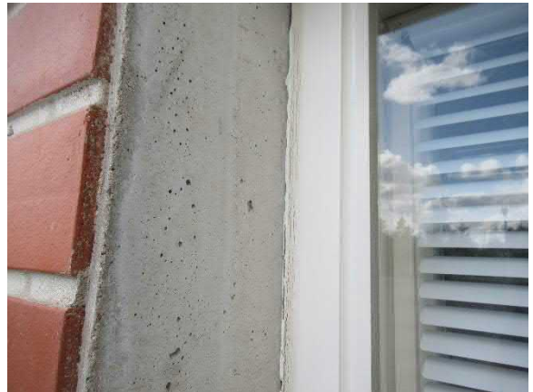
Ikkunoiden ja ulkoseinien liittymiä on tiivistetty massalla
