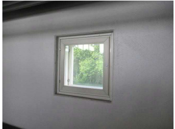
Yleiskuva ikkunoista sisäpuolelta
