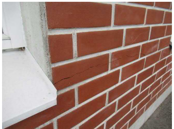
Halkeama tiilimuurauksessa
