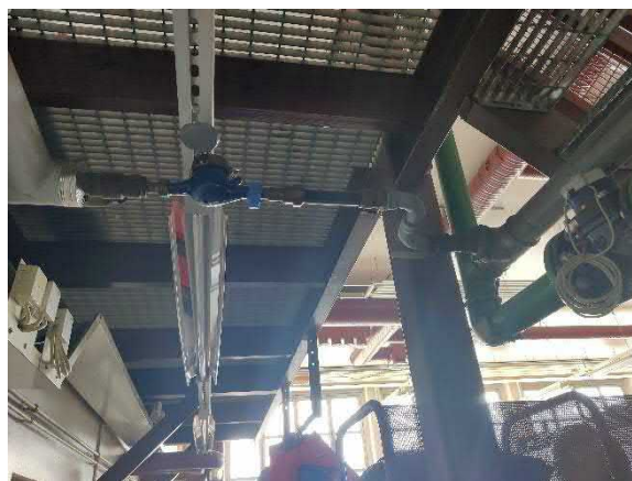
Päävesimittari
