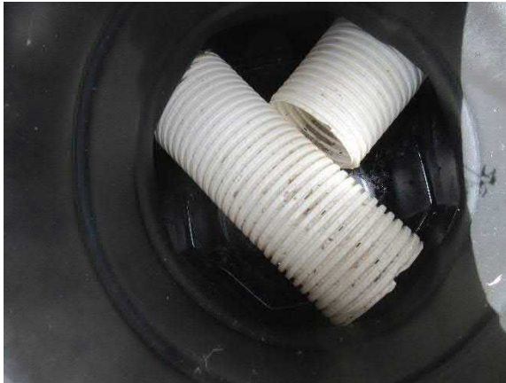
Koilliskulmauksen salaojakaivo, salaojat asennettu ko. kaivon kohdalla lähelle maan pintaa
