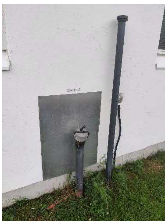
Purkamattomat öljyntäyttö-yhteet.
